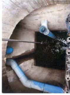
จุดที่ 2 บริเวณถังปรับสภาพสมดุลของระบบบำบัดน้ำ
